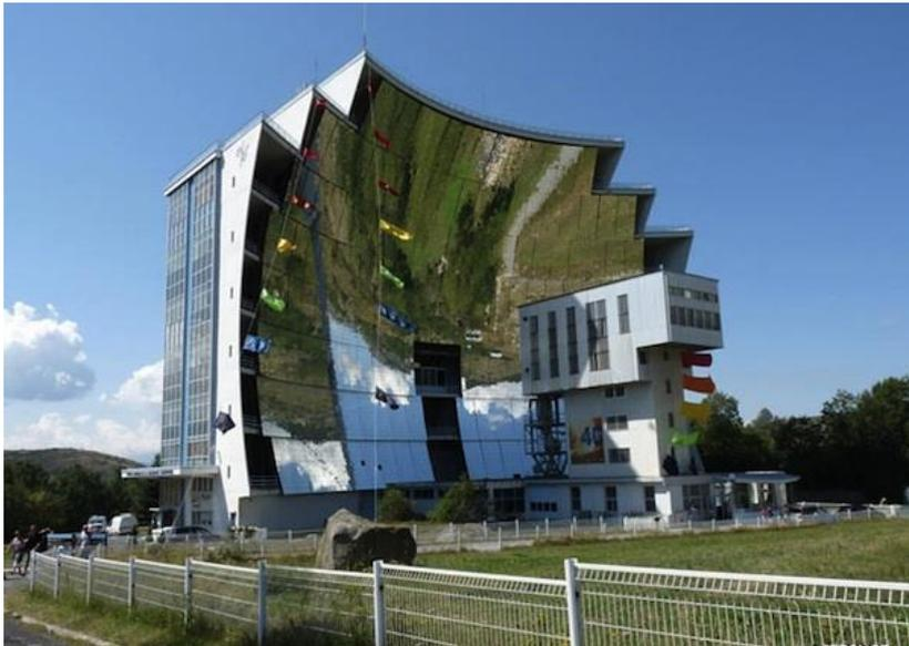
**B2. Hornos solares:** formados por un espejo parabólico que concentra en su foco los rayos provenientes de la reflexión de las radiaciones solares en un cierto número de espejos, llamados heliostatos, convenientemente dispuestos. Estos hornos permiten alcanzar temperaturas muy elevadas (hasta 6000 oC). Suelen emplearse para generar energía eléctrica y con fines experimentales.
