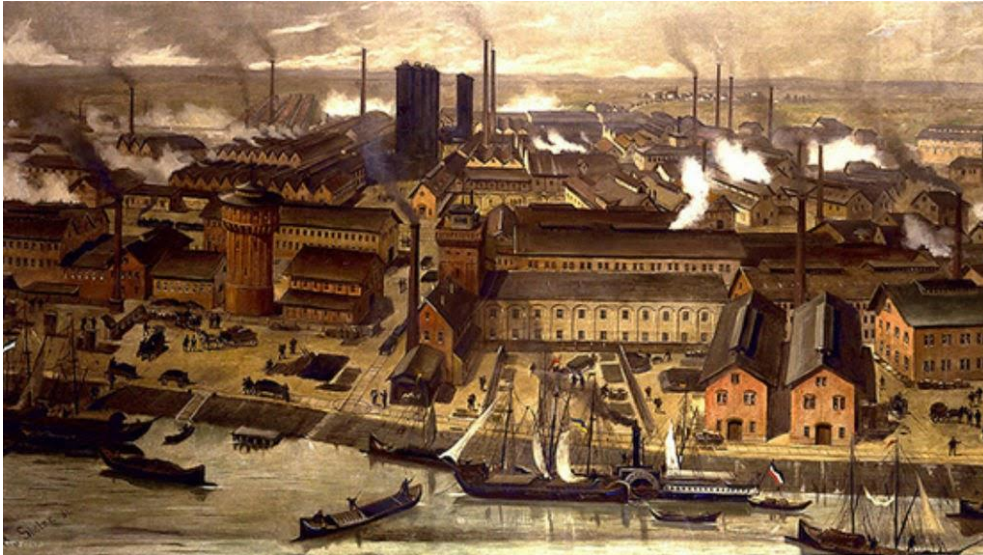
Fábrica de BASF. Alemania 1881
